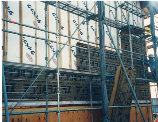
アングルラスLAT型-3施工状況
