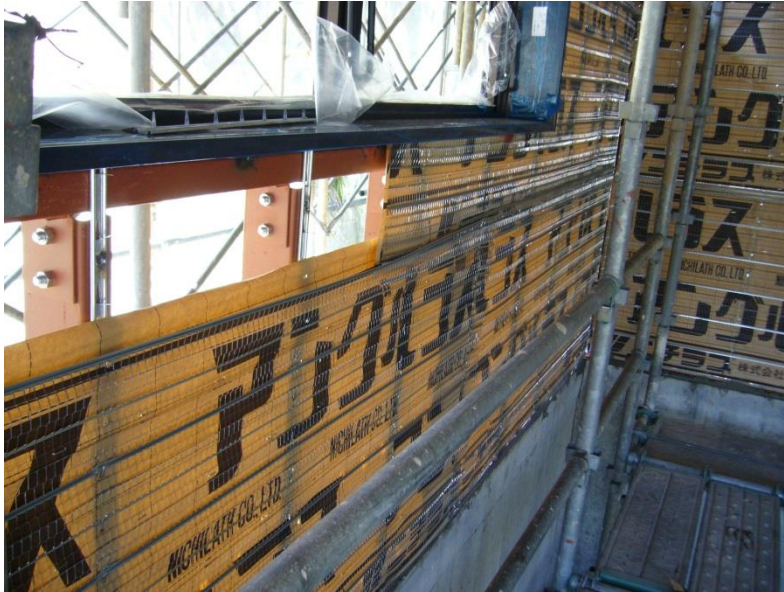
鉄骨縦胴縁にAS824を溶接して下地組の状況
