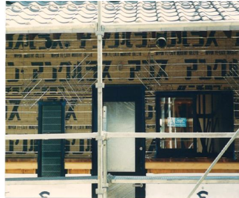
開口廻りの補強ラス施工状況
