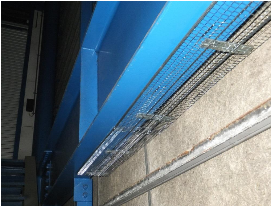
耐火被覆 吹付け下地完成
