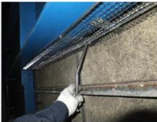
アングルラスのジョイントを 結束線で固定する
