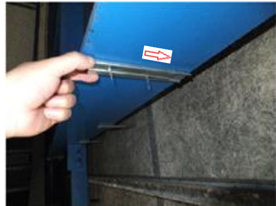
フランジ金物FM型にAS535を スライドして取付け
