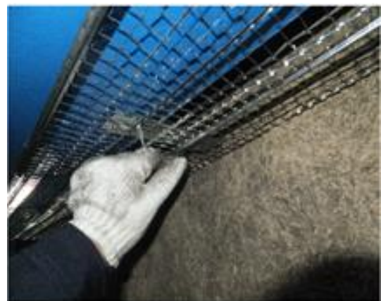
アングルラスを張りAS535の 爪を曲げリブを固定する
