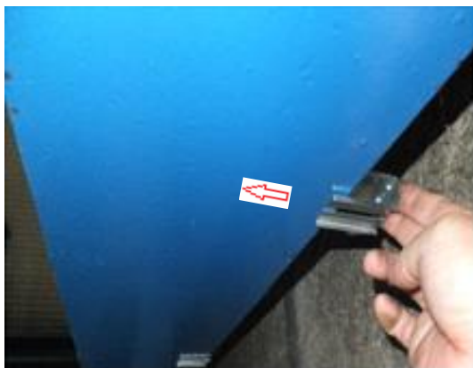
フランジ金物FM型をスライドして 下フランジに取付け
