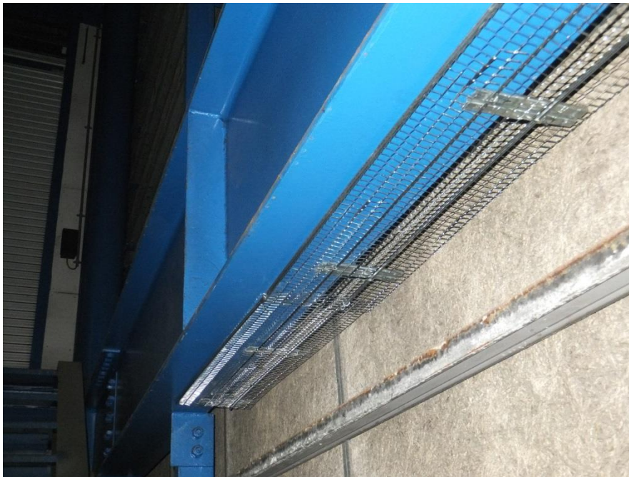
耐火被覆 吹付け下地完成
